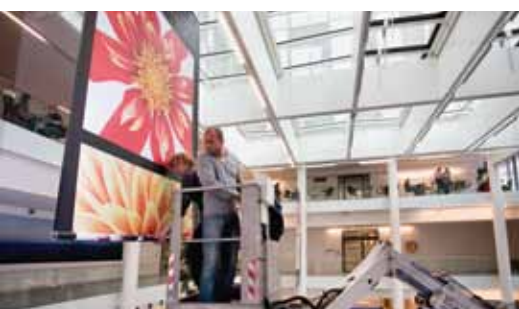
Nur für Schwindelfreie: Mithilfe eines Krans wurde das Ausstellungsplakat angebracht
