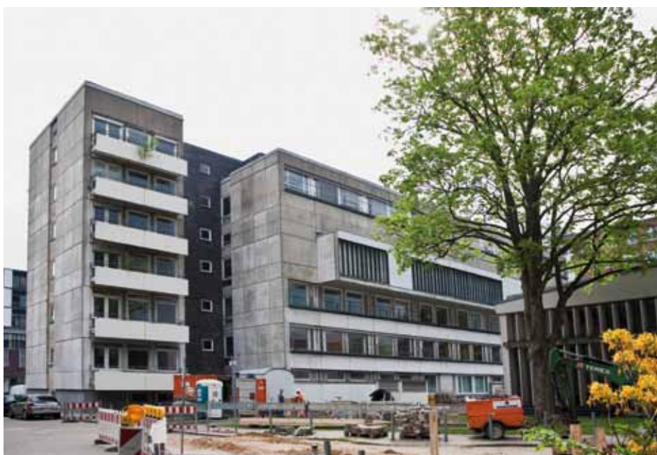
Die ehemalige Frauenklinik heute, kurz vor ihrem Rückbau: Mehr als 100 Jahre war hier der Standort der Klinik, bevor sie 2009 in das Neue Klinikum zog
