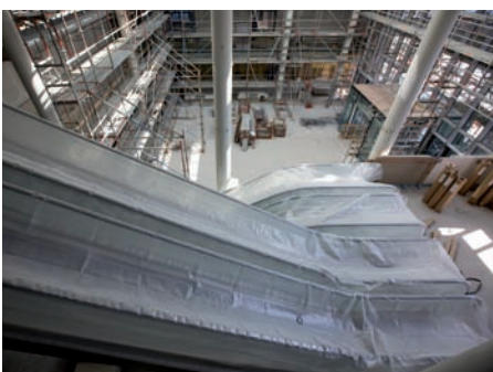
Neues Klinikum: Blick vom zweiten Stock in die Eingangshalle.
