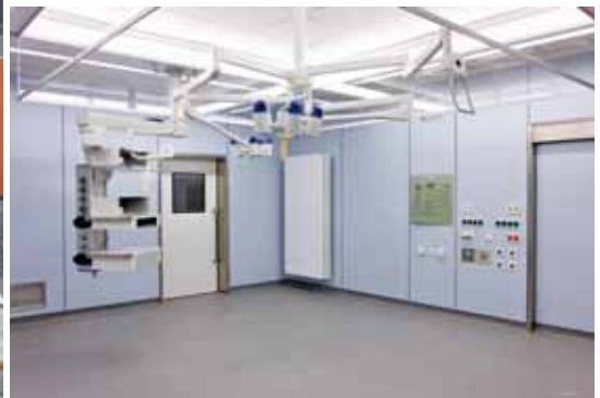
In der ersten Etage sind der OP-Trakt und die Intensivmedizin untergebracht.
