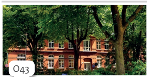
O43 Zweigeschossiger Krankenpavillon
