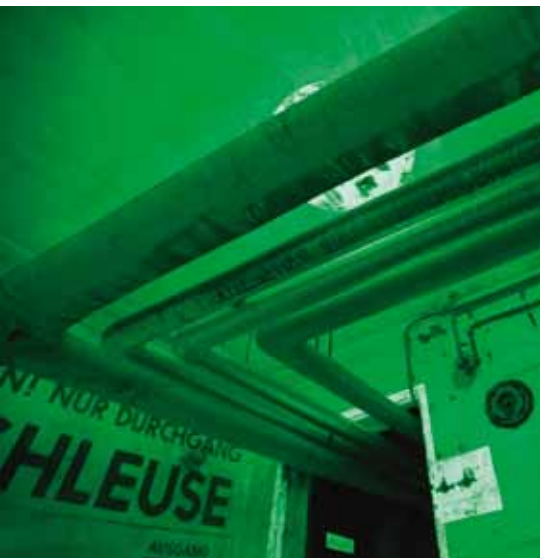
An den Wänden befindet sich noch die originale Leuchtfarbe mit Anweisungen für Notfälle
