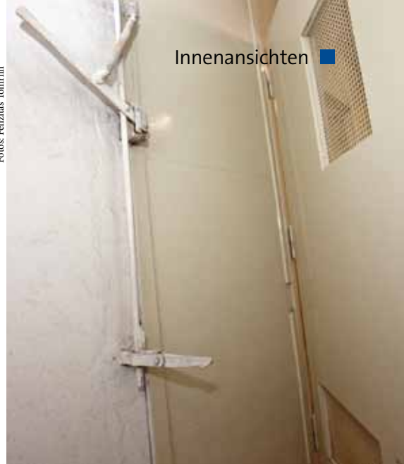
Durch einen speziellen Mechanismus schlossen sich bei Bombenalarm alle Türen gleichzeitig
