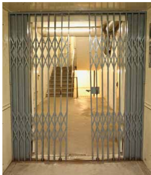
Heute werden im sogenannten OP-Bunker noch eine Reihe alter Akten gelagert
