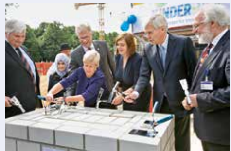
Mit großer Tatkraft wurde der Grundstein im September 2015 einbetoniert
